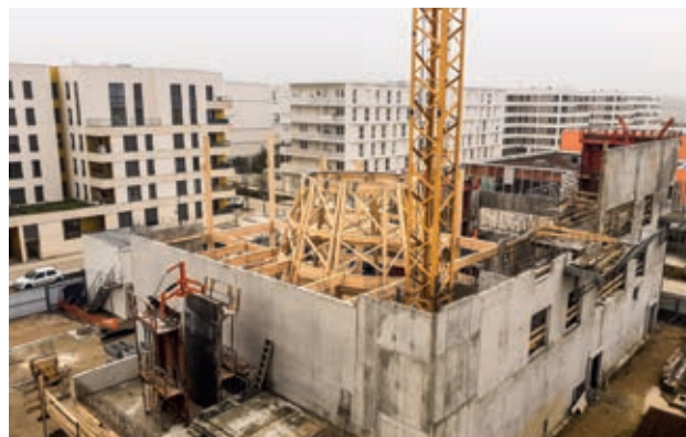
Avancement des travaux en 2021.
